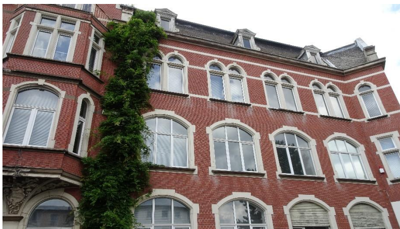
Abbildung 10: Gebäude im Osten des Plangebietes (ISR 2020)
