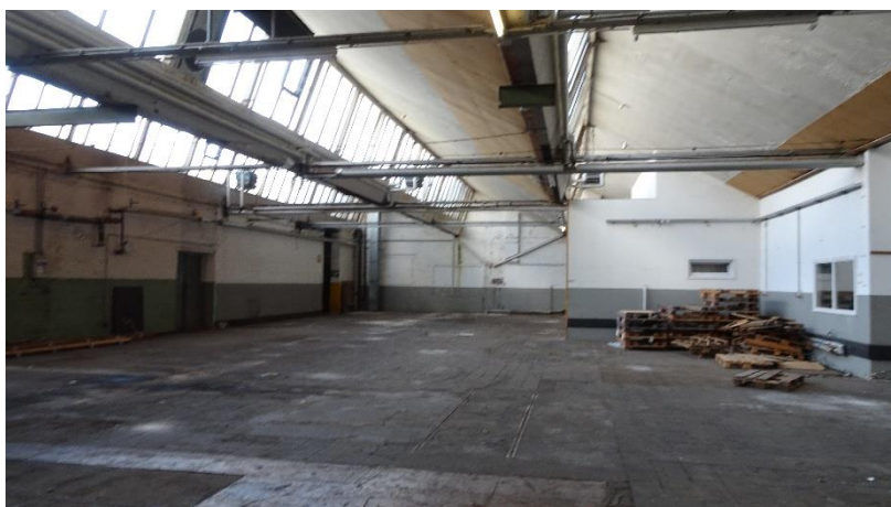
Abbildung 5: Innenbereich der Gewerbehalle (ISR 2020)
