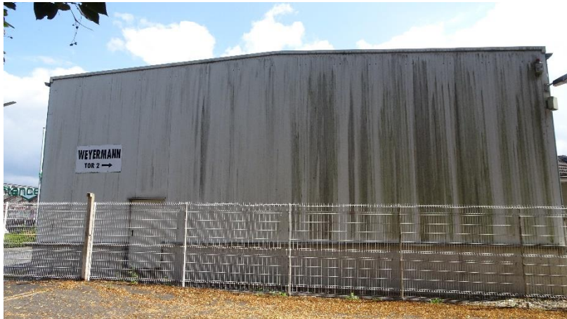
Abbildung 3: westliche Fassade der Gewerbehalle im Plangebiet (ISR 2020)
