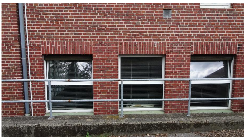
Abbildung 8: halboffenes Fenster (ISR 2020)
