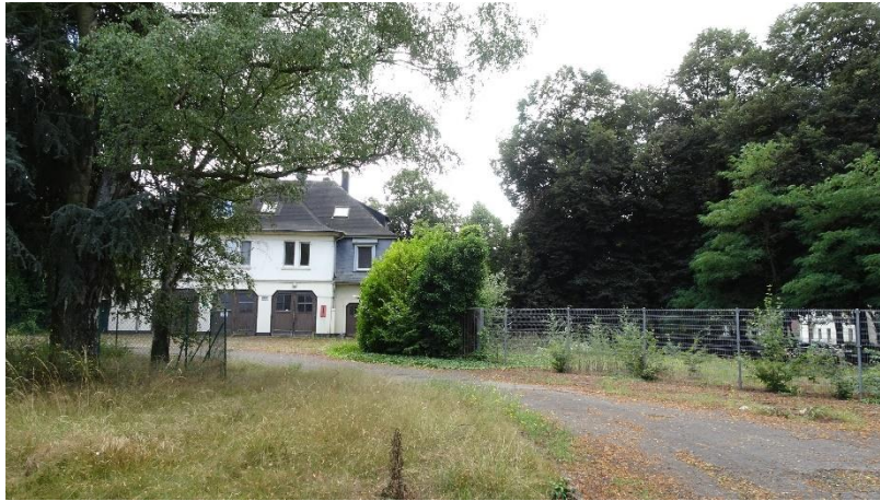
Abbildung 15: tlw. eingefriedete Grünstrukturen im Plangebiet (ISR 2020)
