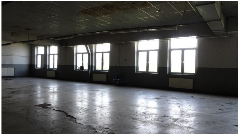
Abbildung 6: Innenbereich der Gewerbehalle (ISR 2020)
