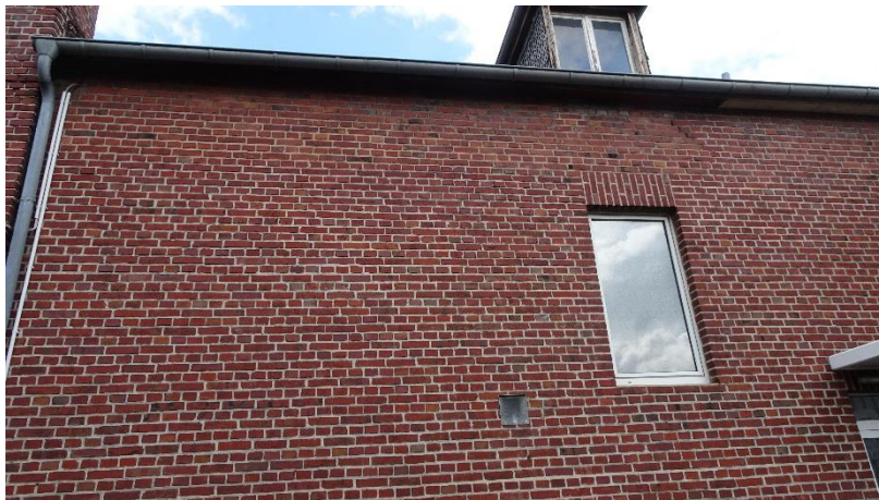
Abbildung 7: intakte Ziegelsteinfassade (ISR 2020)
