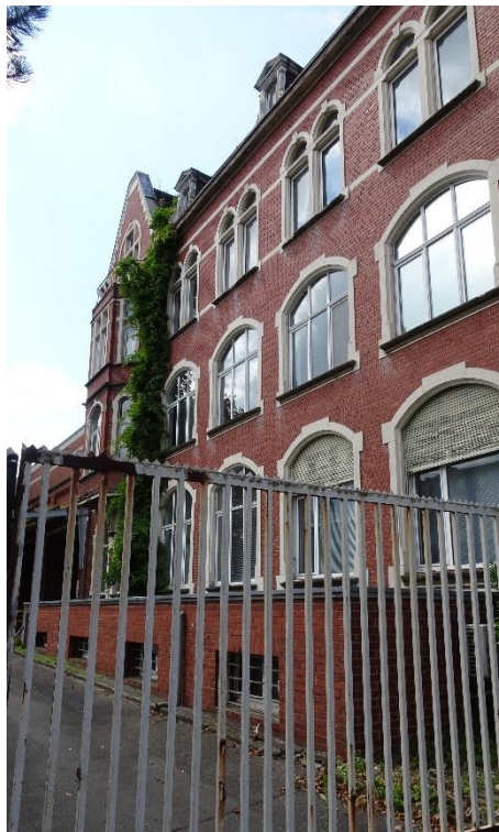
Abbildung 11: Gebäude im Osten des Plangebietes (ISR 2020)
