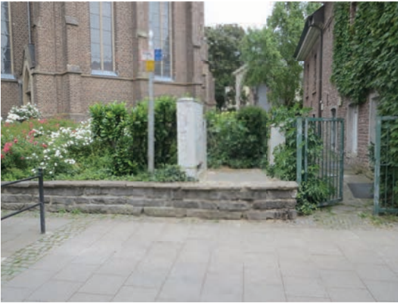
Beete und Schaltschranke
