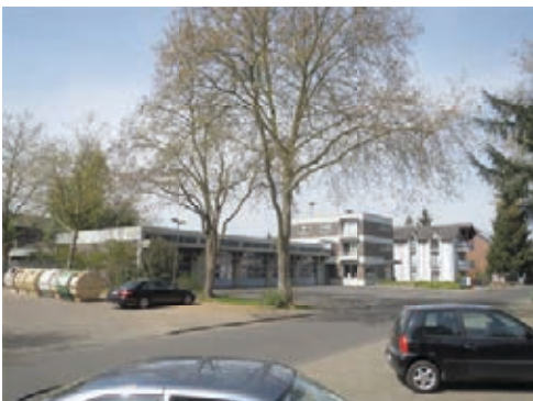
Feuerwehrgerätehaus am St.-Florian-Platz
