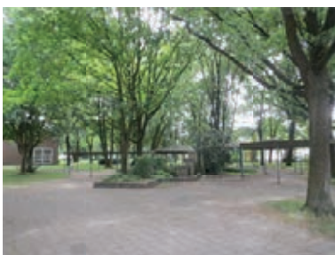
Treppenanlage mit z.T. maroden Pavillongebäuden
