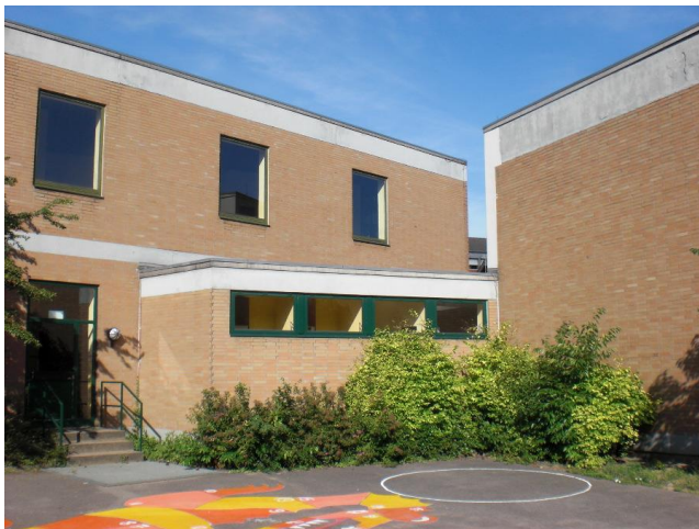
Abbildung 7: Diergardt-Schule auf der Rektoratstraße
