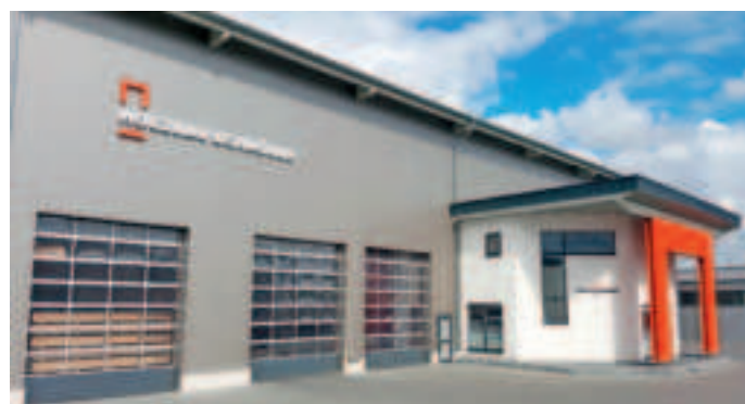
Die Produktionshalle von Holzbau Schröder in Niederkrüchten.
