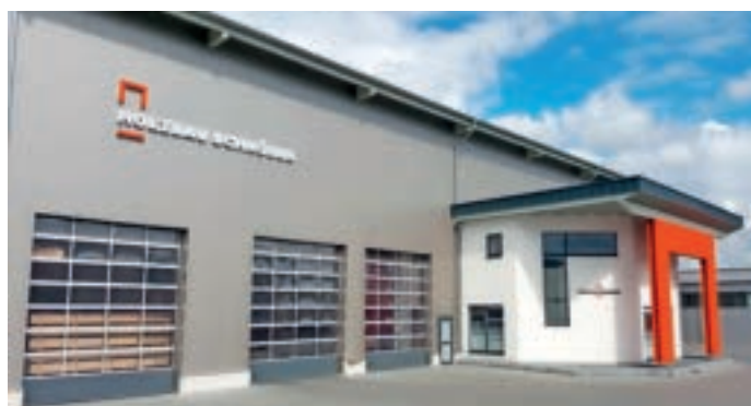
Die Produktionshalle von Holzbau Schröder in Niederkrüchten.
