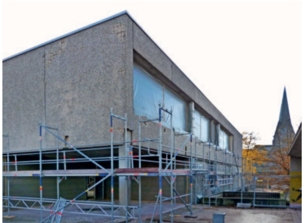
Die Paul-Weyers-Schule in Boisheim wird energetisch saniert. Sie bekommt unter anderem eine regenerative zentrale Heizungsanlage mit Eisspeicher. Foto: Stadt Viersen
