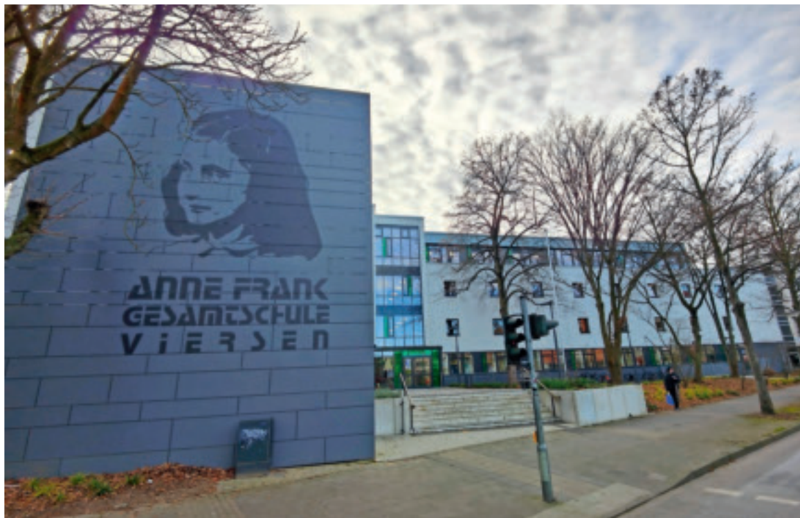
Die Außenanlage der Anne-Frank-Gesamtschule am Standort Lindenstraße ist umgestaltet worden. Foto: Mai
