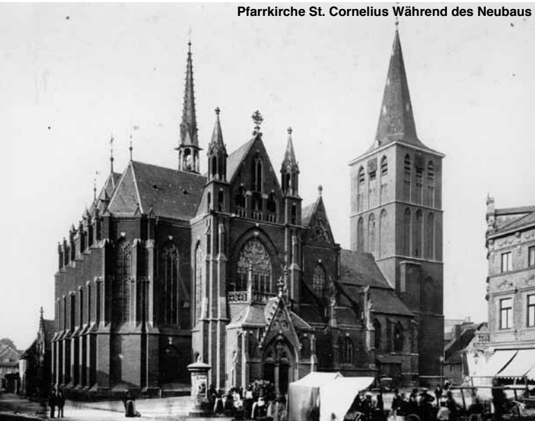
Pfarrkirche St. Cornelius Während des Neubaus
